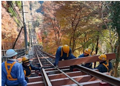
枕木交換工事
