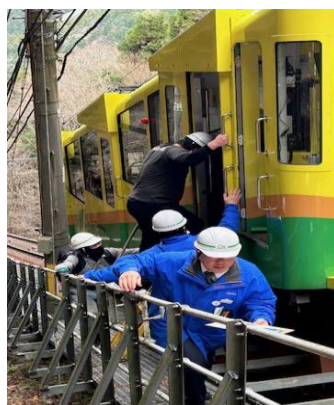
橋梁部での救助作業
