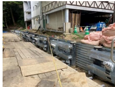
斜面对策工事
