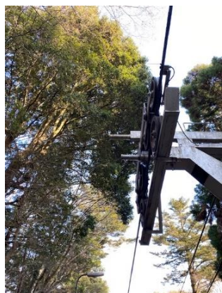
沿線脱索保安装置更新工事
